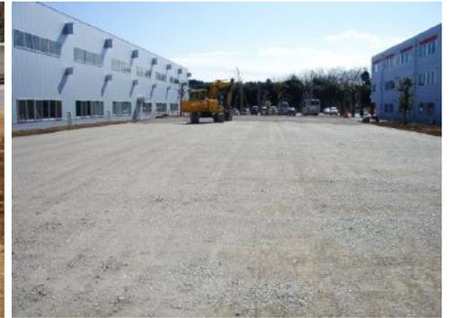
再生碎石砂目潰し転圧面コーンα 散布浸透改良状況
