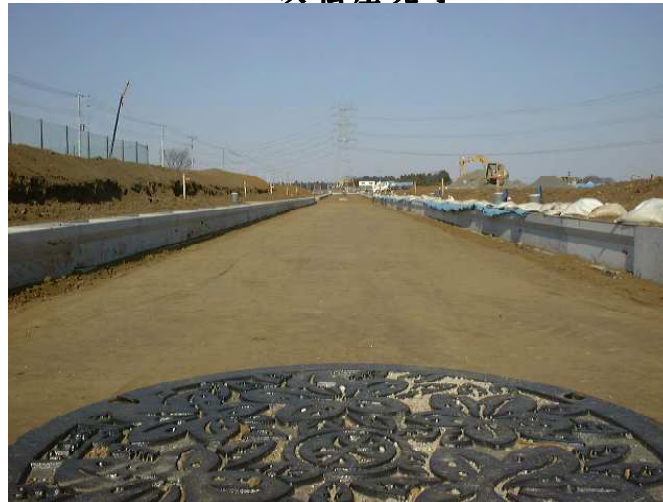
一次転圧完了
