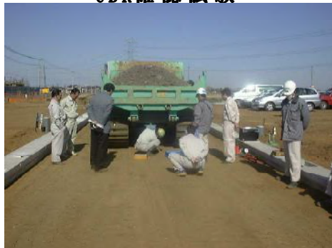
CBR確認試験
