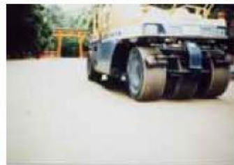
転圧(仕上げ転圧)状況
