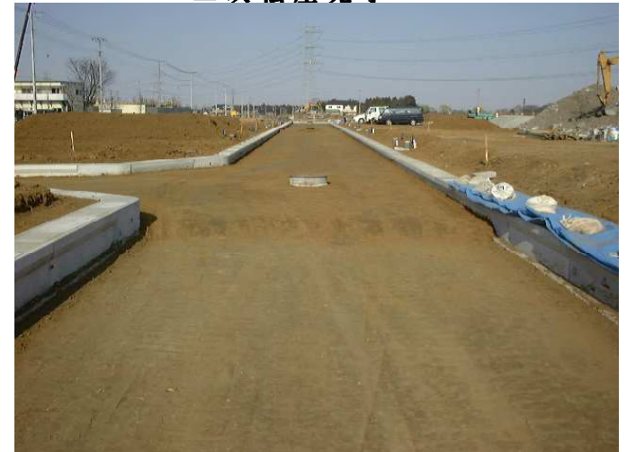
二次転圧完了
