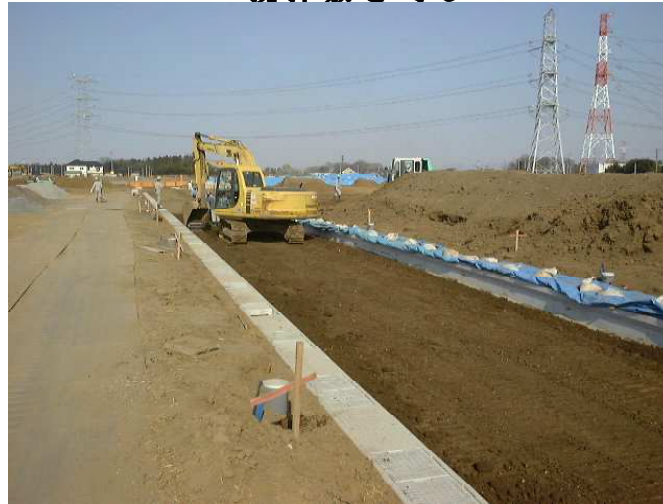
攪拌敷き均し
