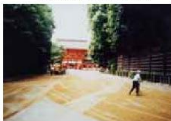
補充材敷均し状況
