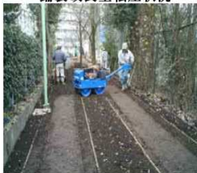
舗装改良土転圧状況
