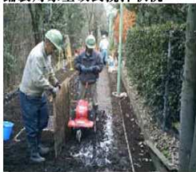
施工写真 舗装対象土改良攪拌状況
