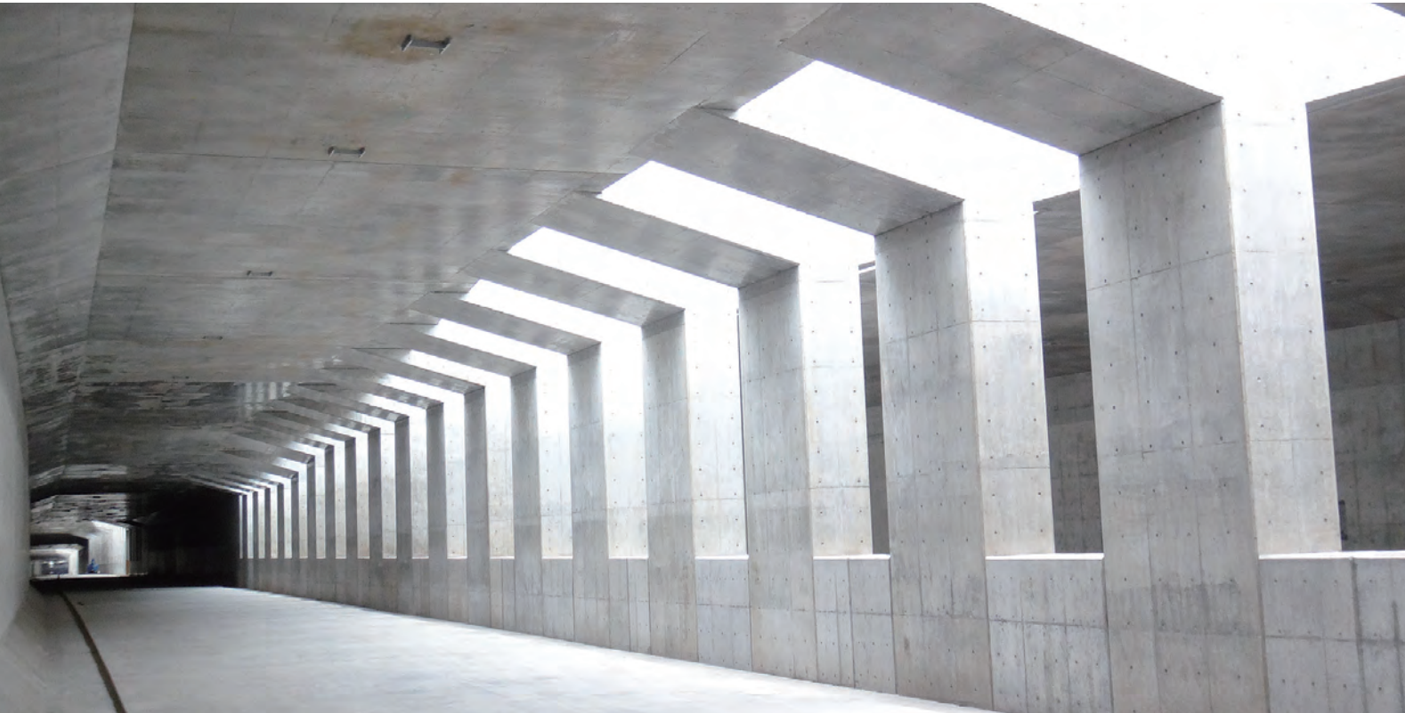
東京外環自動車道 大和田工事 千葉県
